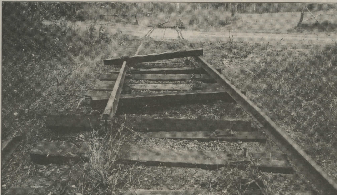
Arbetet med att riva upp spår och sliprar på Vartoftabanan ska vara slutfört innan årets slut, meddelar Banverket i Falköping.
