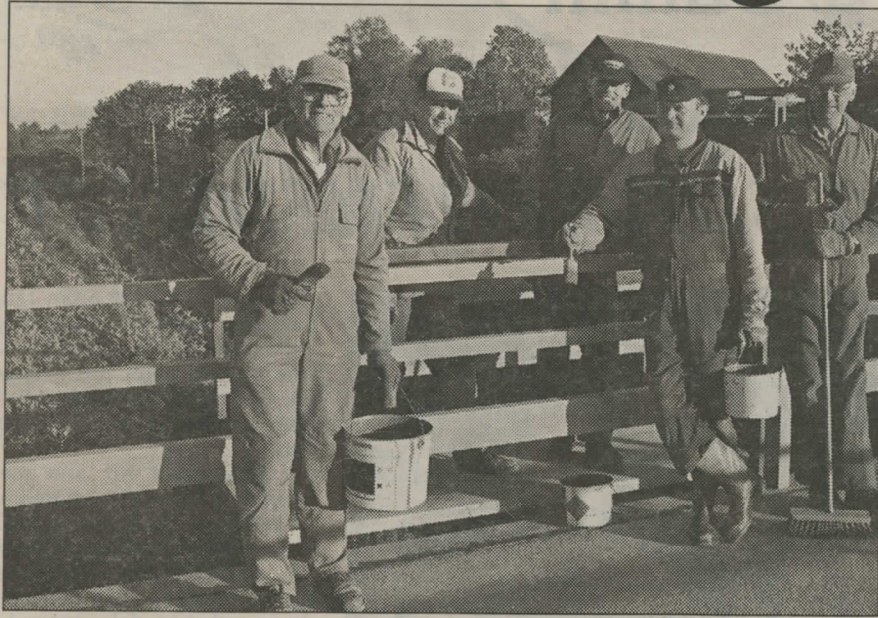
På bilden ses fr.v. Knut Ericson, Karl-Anders Andersson, Lennart Neuman, Johny Johansson och Martin Neuman i färd med målningsarbetet.
