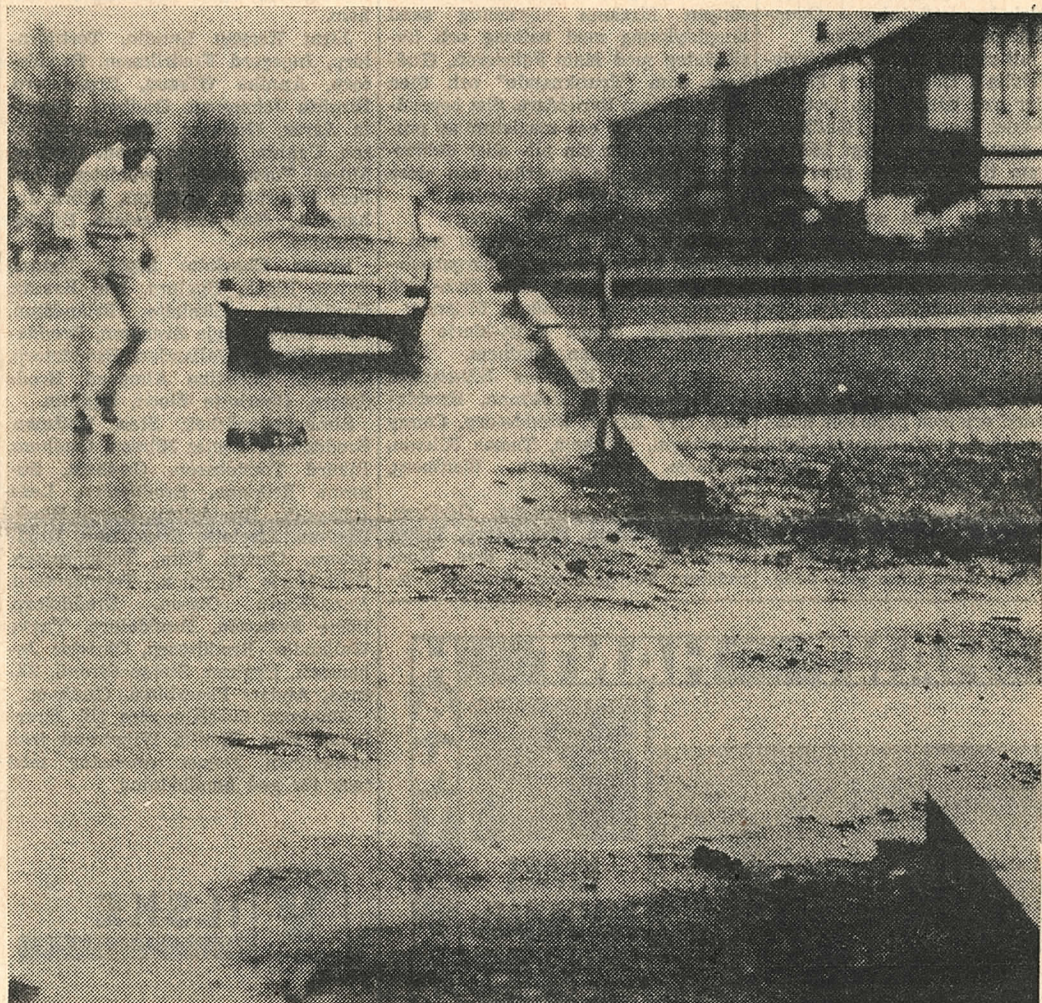
...eller den här gatubrunnen att svälja vattenmassorna.
