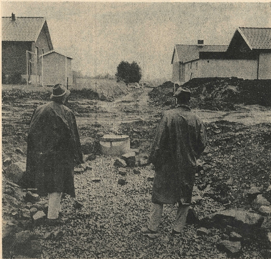
Riktigt överens med kommunen om lösningen av dagvattnet i villaområdet kring Vallgatan är inte villor- nas ägare. Vid skyfall och snabb snösmältning förmår inte den här s.k. stenkistan...
